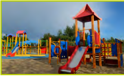
1 Budowa placu zabaw ul. Tużyckiej
