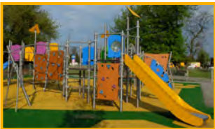
25 Budowa placu zabaw przy Domu Kultury Zacisze
